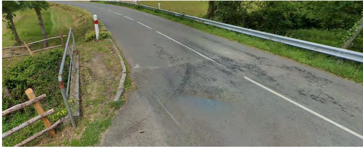
Figure 101. Petit pont franchissant le ruisseau de la Villonière au niveau de la D88 © Google 2022 (mai 2021)
