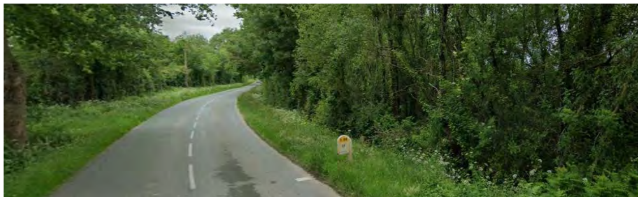
Figure 98. Affluent du Tourteron au niveau de la D88 (avec buse permettant le franchissement du ruisseau) © Google 2022 (mai 2021)
